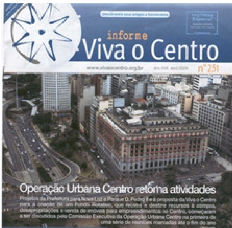
Figura 1. Boletim “Informe Viva o Centro”: exemplo de empreendedorismo urbano através da associação público-privado. Fundada em 1991, liderado pelo Banco de Boston, a “Associação Viva o centro” atualmente põe em pratica varias projetos de intervenção urbanística ao redor do Centro histórico da cidade de São Paulo. Tornou-se uma das mais importantes associações lideradas por setores corporativos que influenciam as “Operações Urbanas”, como a “Operação Urbana Centro”. Fonte: “Informe Viva o Centro” Ano XVII Abril 2009, n°. 251.
