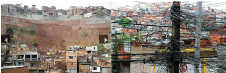
Figura 5. Deslizamento de terra no Morro dos Macacos, Zona Sul de São Paulo, com 2 mortos e 59 casas interditadas. Fonte: http://tudoglobal.com/ (08/07/2011); As ligações clandestinas de eletricidade, chamadas de “Gatos”, chegam a 45 mil no município de São Paulo. Fonte: http://www.band.com.br/noticias/cidades/noticia/?id=306537 (25/05/2010).
