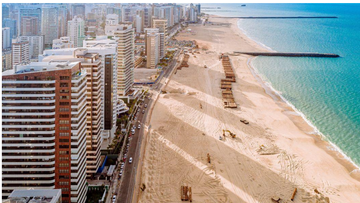
Figura 2: Obra de aterro da orla turística de Fortaleza na Praia de Iracema em 2019 para requalificação da Avenida Beira-Mar.
