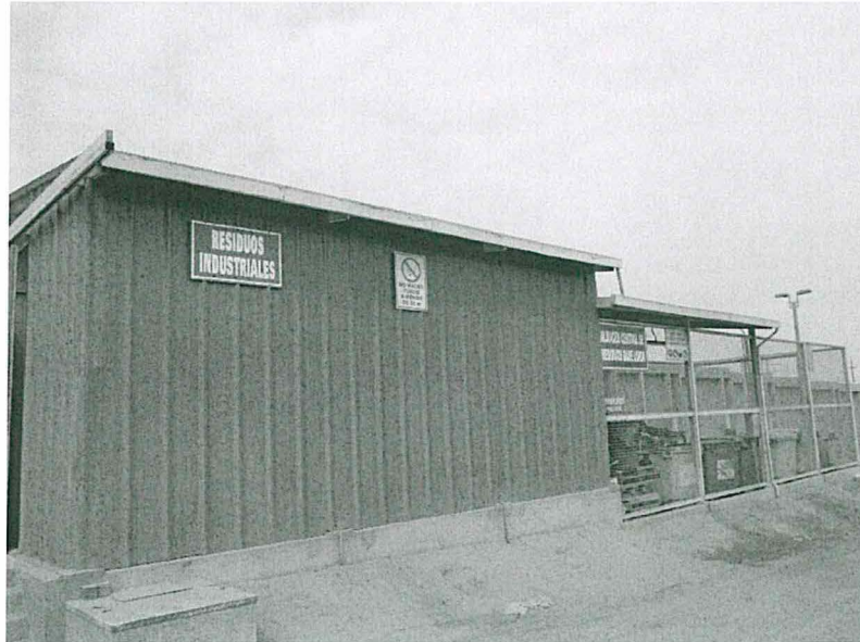
Fotografía N° 13. Área de las instalaciones del almacén de residuos industriales, base Lurín
