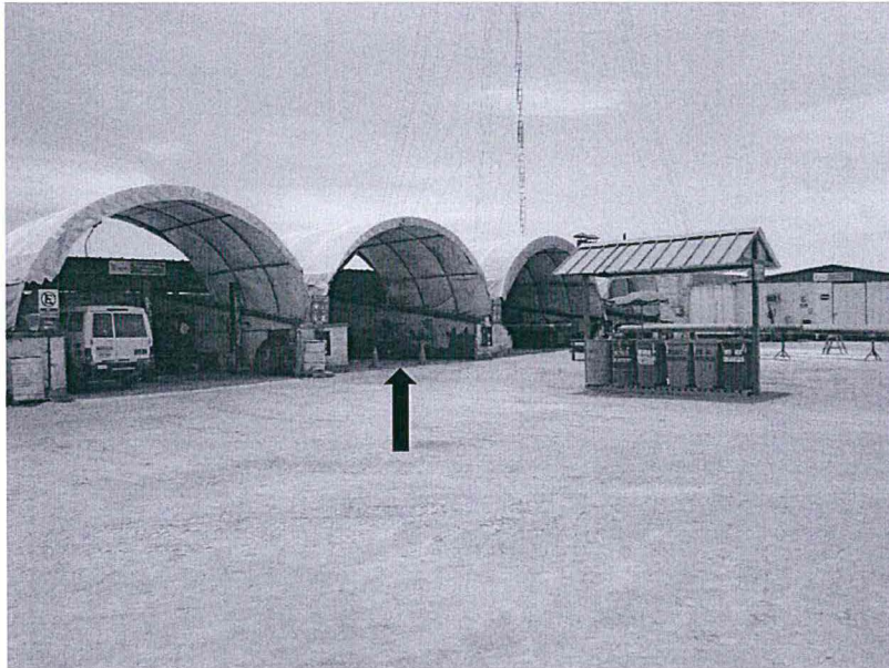
Fotografía N° 15. Área de las instalaciones del taller de herrería, base Pisco
