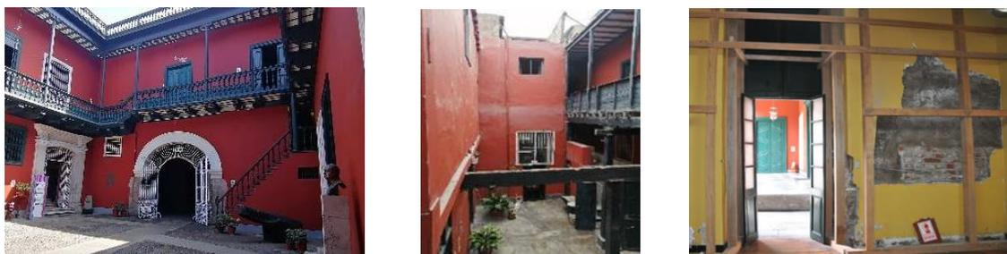
*Figura 46:* Muros de la Casa Riva-Agüero. (Izq.) Muros de adobe en el patio N°110, (centro) tabiques de quincha en patio N°131 y (der.) calzaduras de ladrillo en N°114. Fuente: Expediente técnico de la empresa Restauero.
