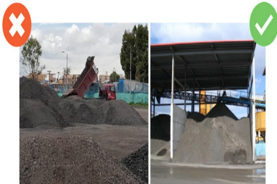
Figura N°8. *Almacenamiento del pavimento asfáltico reciclado.*
