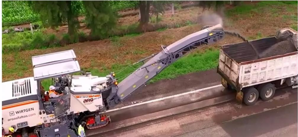
Figura N°19. *Extracción del material envejecido a reciclar*
