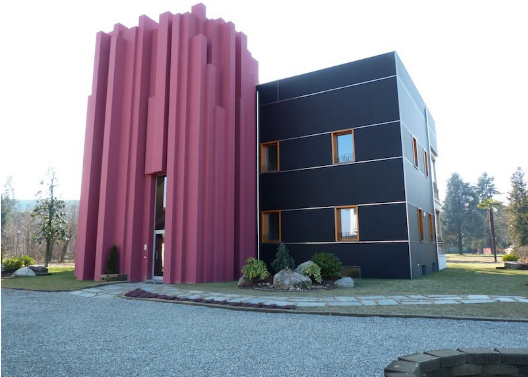
Vista del corpo tecnologico esposto a nord
