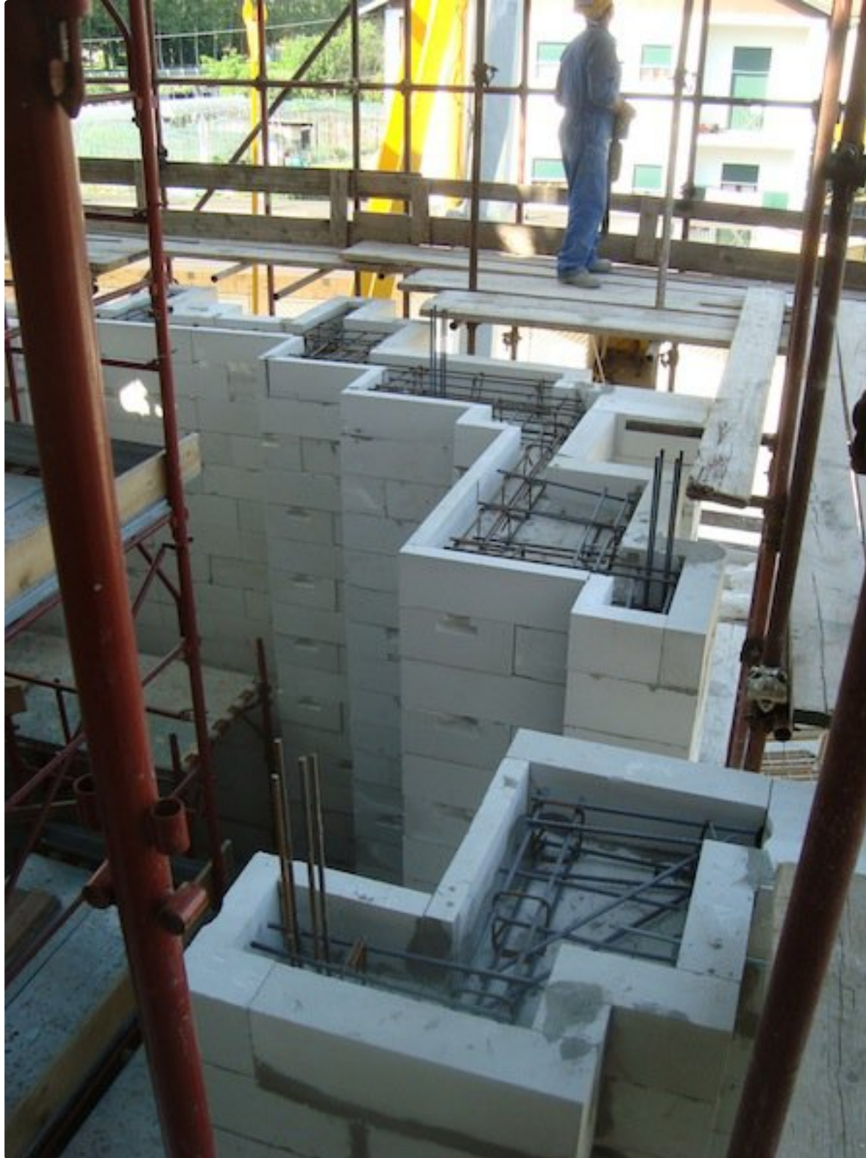
Costruzione del corpo tecnologico
