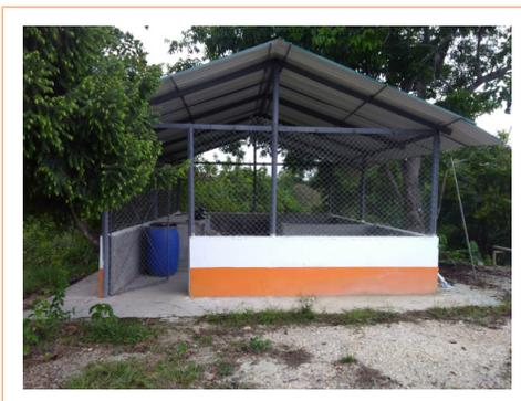
La planta tiene la capacidad para realizar tres compostajes simultáneamente, debido a que está construida con tres pilas.
