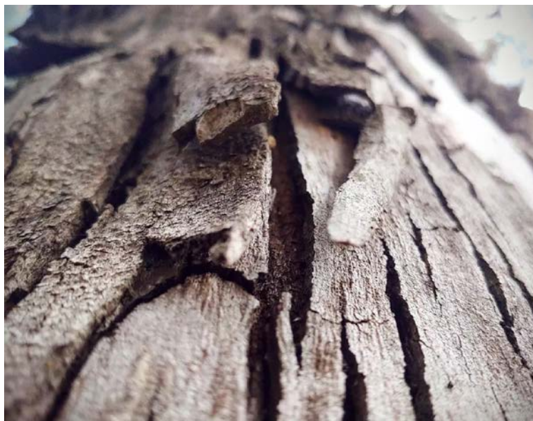
Foto 4. Grietas . Carla Pedrazzani, digital, 2022.
