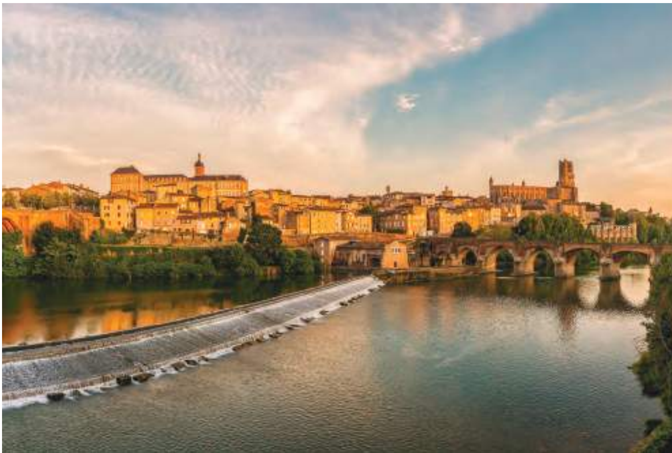
fig. 4. Il complesso episcopale di Albi, vero e proprio nucleo fortificato all'interno della città, dalla quale emerge nel lato destro dell'immagine. La torre campanaria absidale della cattedrale di Sainte-Cécile si palesa inequivocabilmente come un donjon (foto Wikimedia Commons).
