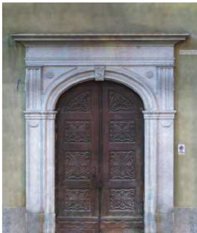
fig. 5 – Il portale del Seminario Diocesano di Acqui Terme, caso di specchiatura ottocentesca in granito bianco applicata ad una facciata eretta nel corso del XVIII secolo, qui riportata per completezza. Ortofoto, non in scala grafica, non in proporzione.
