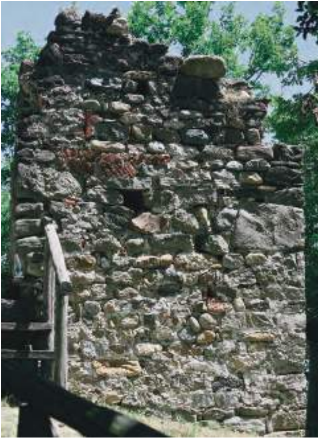
fig. 5 – Mombasiglio (CN), chiesa di Sant'Andrea: fase 3, porzione di facciata conservata a destra del portale (usm 8).
