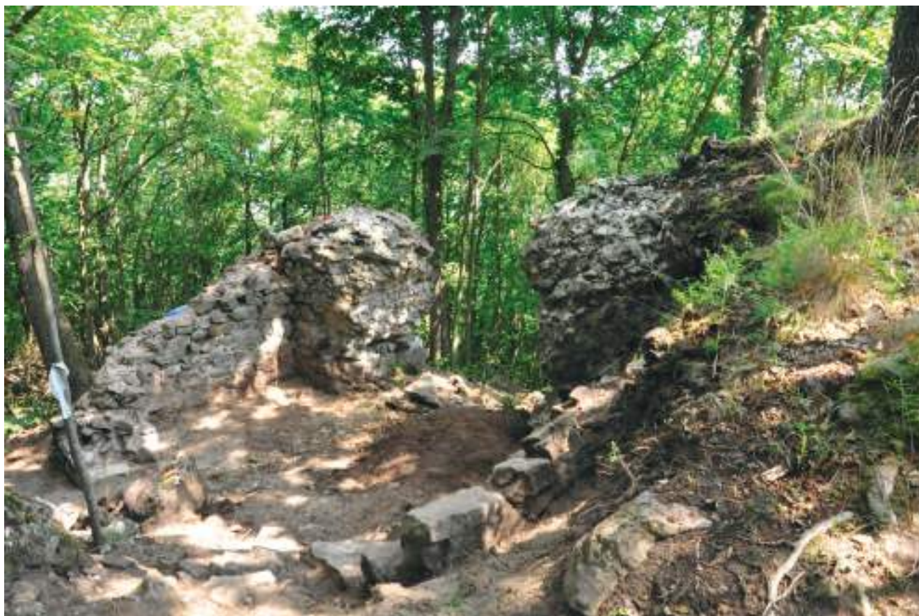
fig. 1 – Bagnasco (CN), sito di Santa Giulitta: area della porta.
