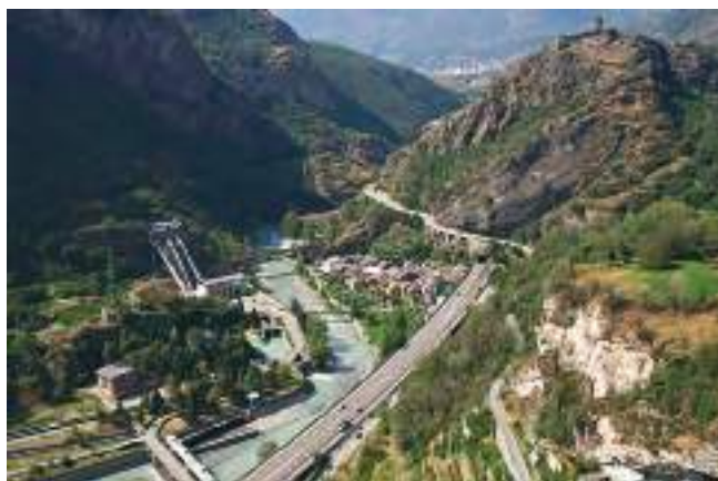
fig. 6 – Il borgo di Montjovet nel contesto territoriale contrassegnato da un’estesa infrastrutturazione.
