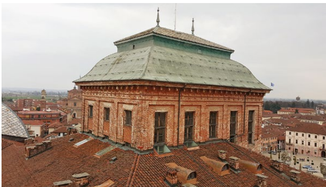
fig. 1 – Castello di Racconigi. Copertura del corpo centrale, sopra il Salone d’Ercole, vista dal Belvedere ovest.
