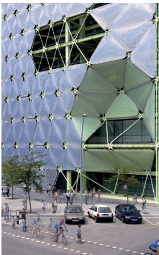
Fig. 3 – Ingresso principale dell'edificio evidenziato dalla concavità strutturale dei moduli triangolari della facciata in ETFE, la cui serigrafia pigmentata di verde è costata a Vector Foitec due anni di ricerca e sviluppo, al fine della stabilità ai raggi UV (© Cloud 9 – Luis Ros)
