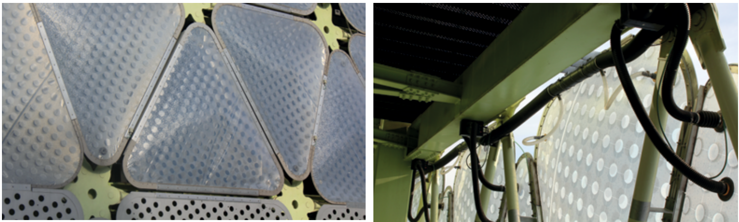
Fig. 22 – La struttura complessa ad aste è stata realizzata tramite estrusione e la forma triangolare dei cuscini ha richiesto lo sviluppo di dettagli speciali in acciaio inossidabile; la forma dei cuscini triangolari, conseguenza diretta della maglia delle aste di controvento delle facciate, è arrotondata agli angoli, con curvature a raggi variabili, per mettere in mostra i giunti a “fiore” (© Cloud 9)
