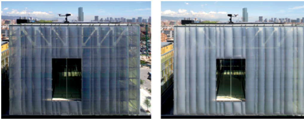
Fig. 10 – Effetto della variazione della trasparenza/opacità della facciata S-O tramite la generazione di nebbia artificiale con insufflaggio di azoto e olii (© Cloud 9 - Gunnar Knechtel – Luis Ros)
