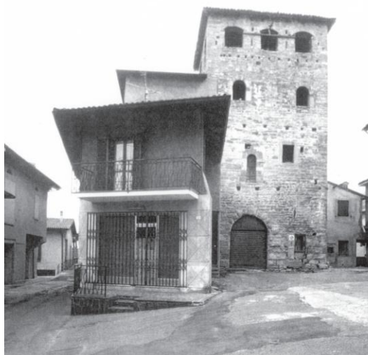
Figura 7 – Vista della torre e della piazza prima dei lavori
