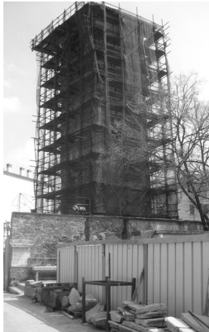
Figura 13 – Stato attuale della torre con ponteggi strutturali
