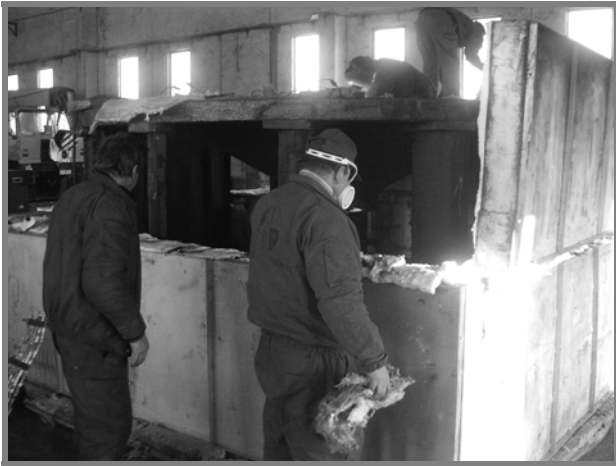
Slika 10: Izgled peći za naponsko žarenje nakon reparaturnog navarivanja
