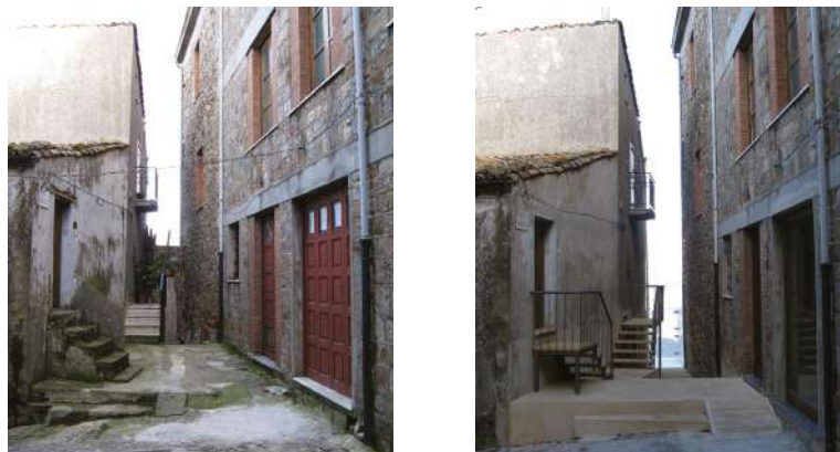
Fig. 1-2. Vista del vicolo Mendolilla, prima e dopo la realizzazione dei lavori.
