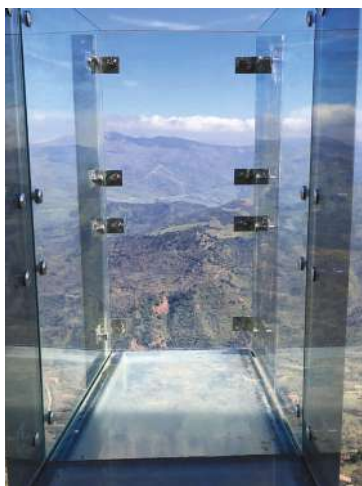
Fig. 3 Dettaglio del balcone aggettante in acciaio e vetro strutturale (foto di G. Salmeri).
