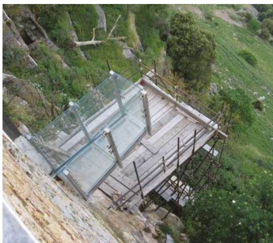
Fig. 3 Dettaglio del balcone aggettante in acciaio e vetro strutturale (foto di G. Salmeri).
