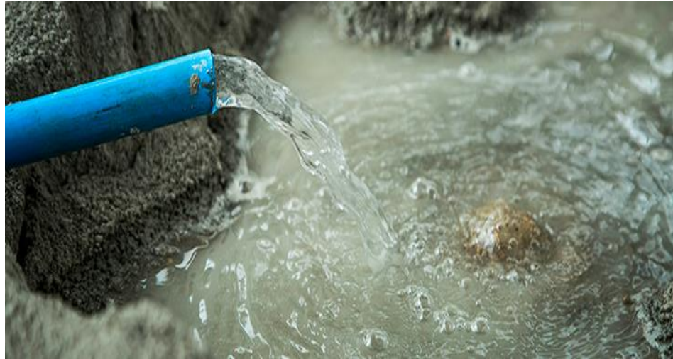
Ilustración 8 Agua en el concreto Fuente: Maestro – Construye Bien
