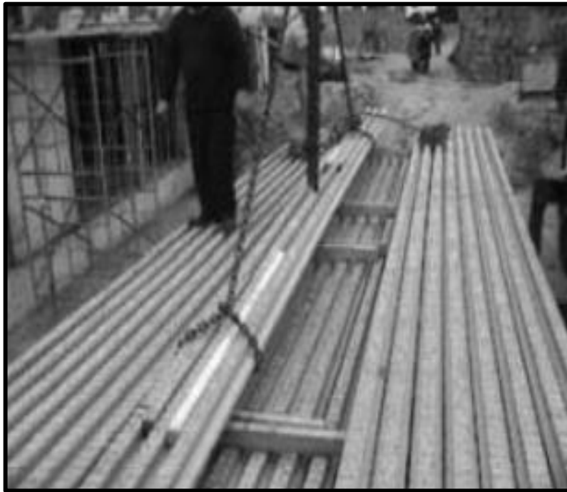
Izaje con grúa Fuente: (manual viguetas firth)
