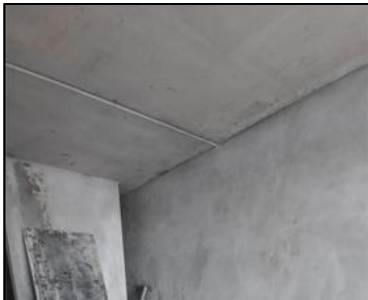
Figura 19. Acabado de losa aligerada con prelosa Fuente: (propia 2021)
