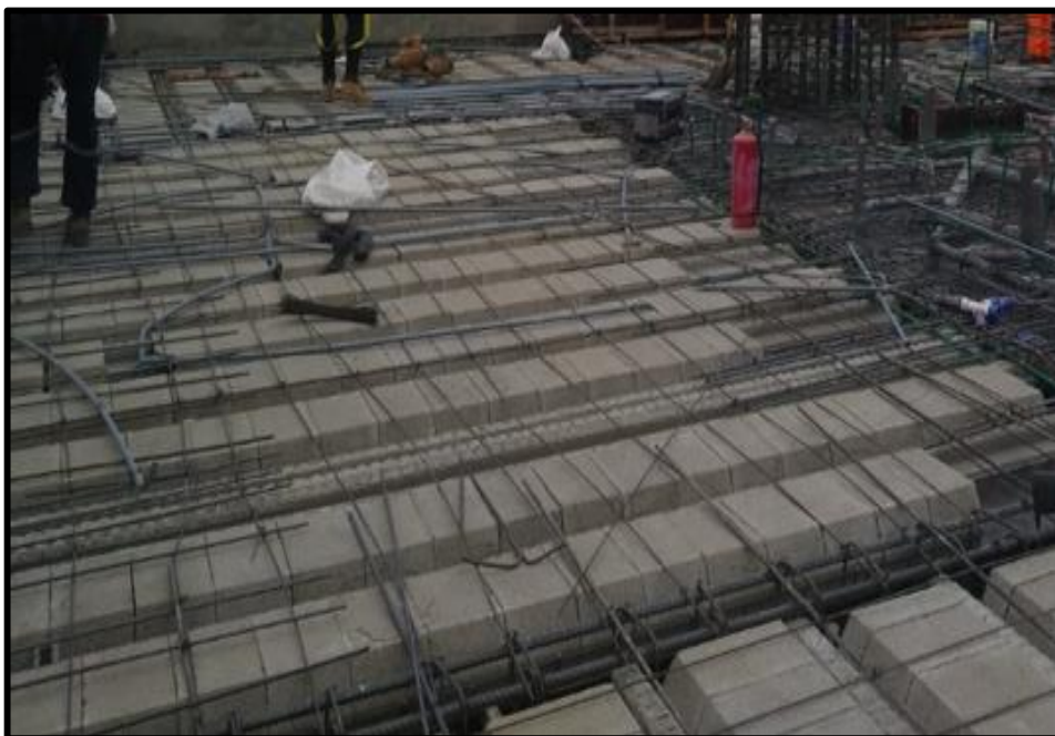
Colocación de acero de temperatura Fuente: (propia 2021)
