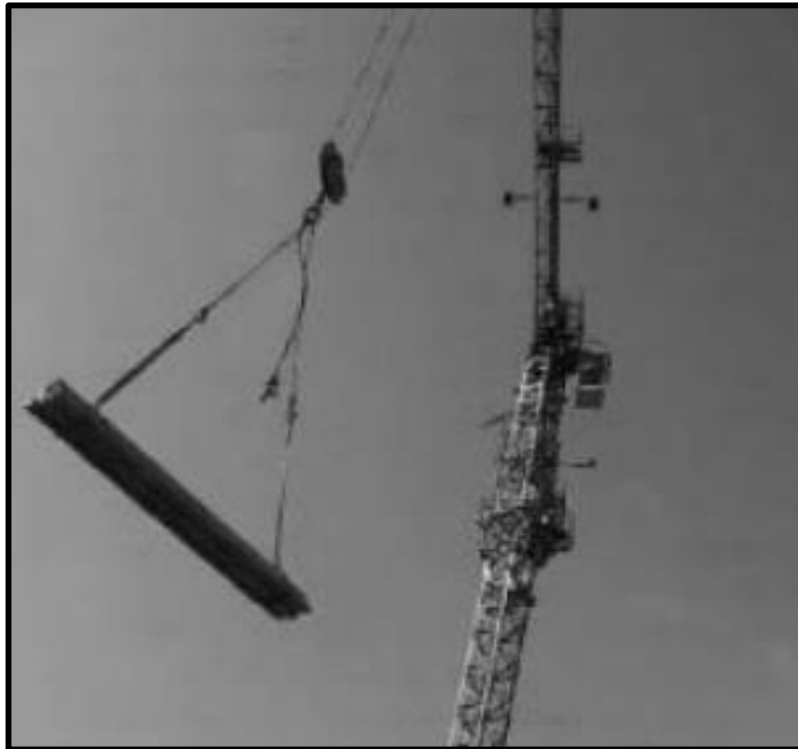
Izaje con grúa Fuente: (manual viguetas firth)
