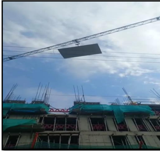
Izaje de prelosa Fuente: (propia 2021)
