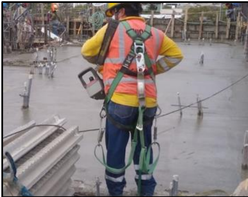
Vaciado de concreto Fuente: (propia 2021)
