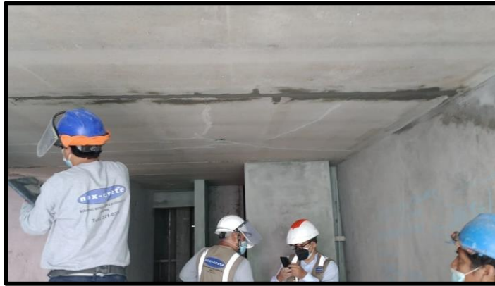
Sellado de junta Fuente: (propia 2021)
