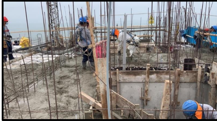
Vaciado de concreto Fuente: (propia 2021)
