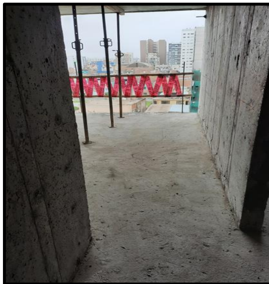
Desenclafado de losa Fuente: (propia 2021)
