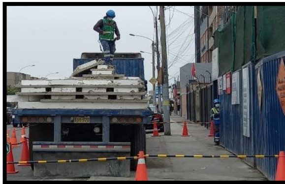
Verificación de prelosa según sectorización Fuente: (propia 2021)
