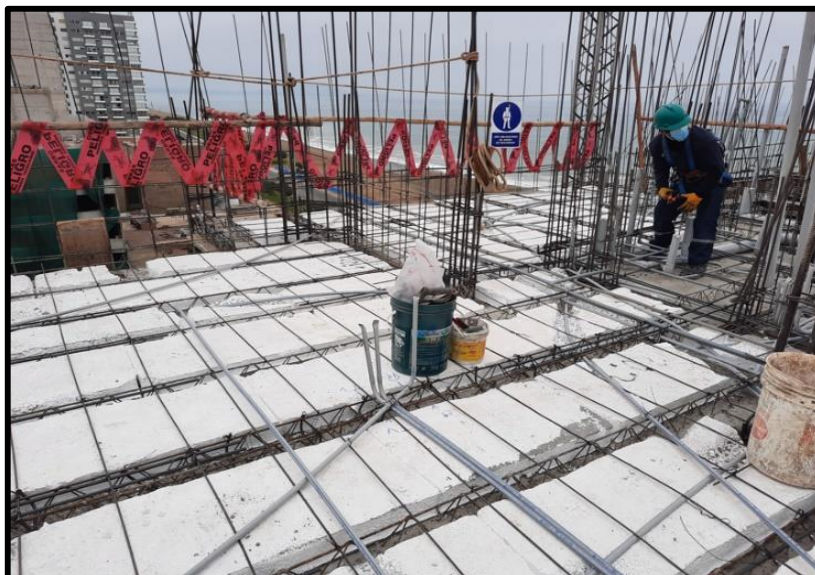
Tendido de tuberías eléctricas Fuente: (propia 2021)
