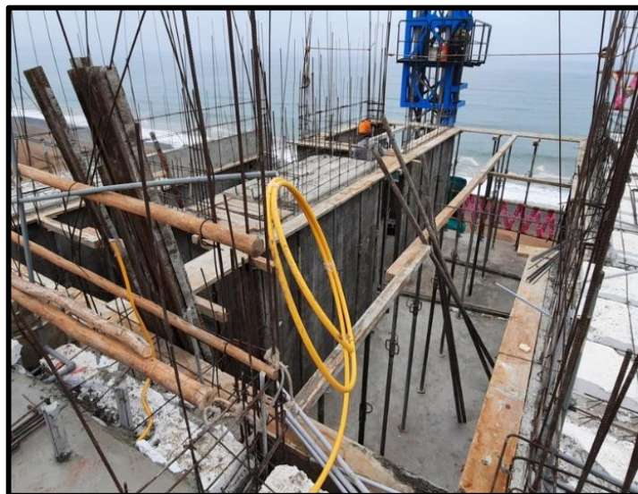
Encofrado Fuente: (propia 2021)
