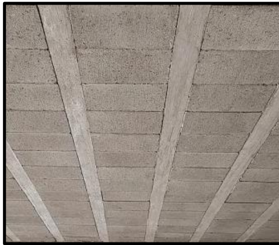
Figura 18. Losa aligerada luego del desencofrado Fuente: (propia 2021)
