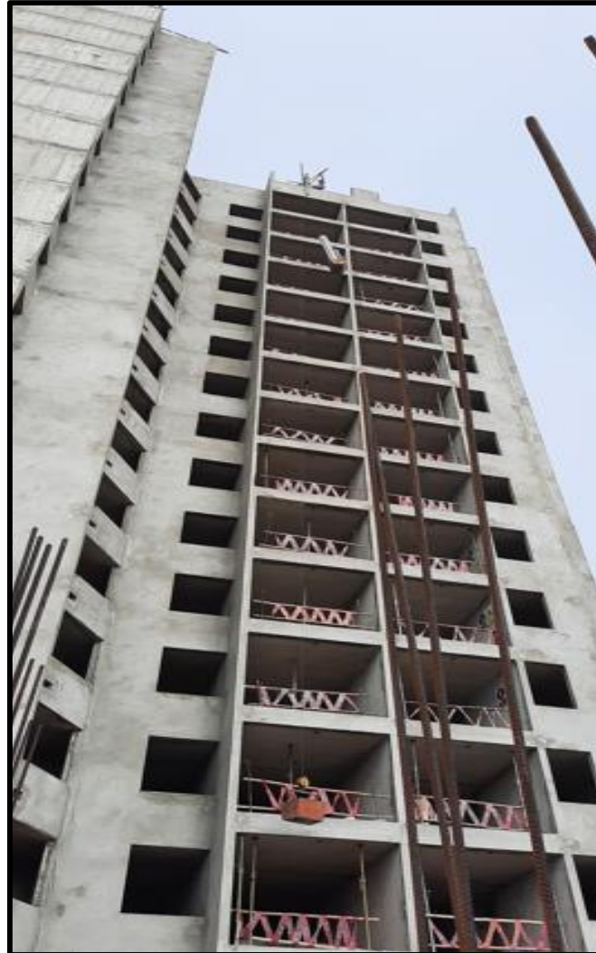
Izaje con winche Fuente: (propia 2021)
