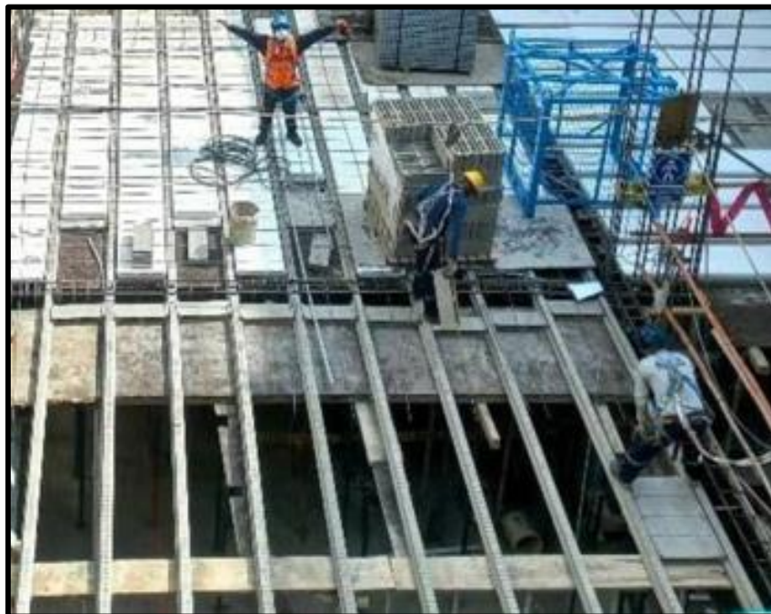
Colocación de viguetas Fuente: (propia 2021)
