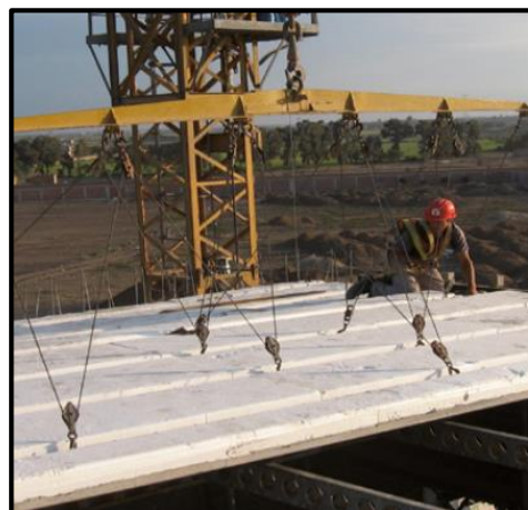
Figura 9. Izaje de prelosa Fuente: (ENTREPISOS)
