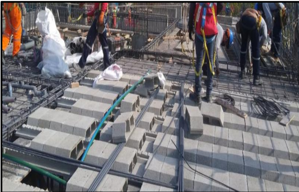
Colocación de bovedillas Fuente: (propia 2021)
