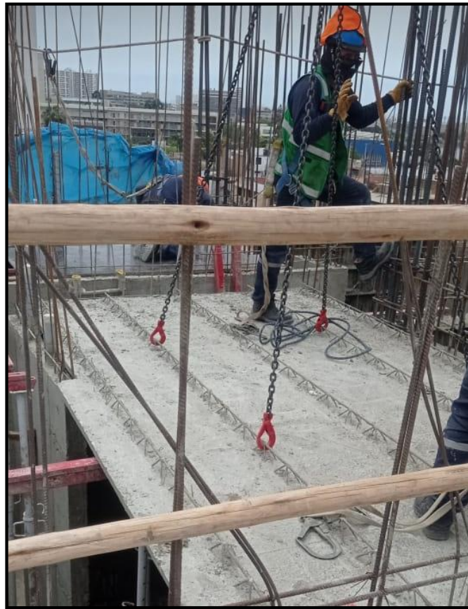
Colocación de prelosa Fuente: (propia 2021)
