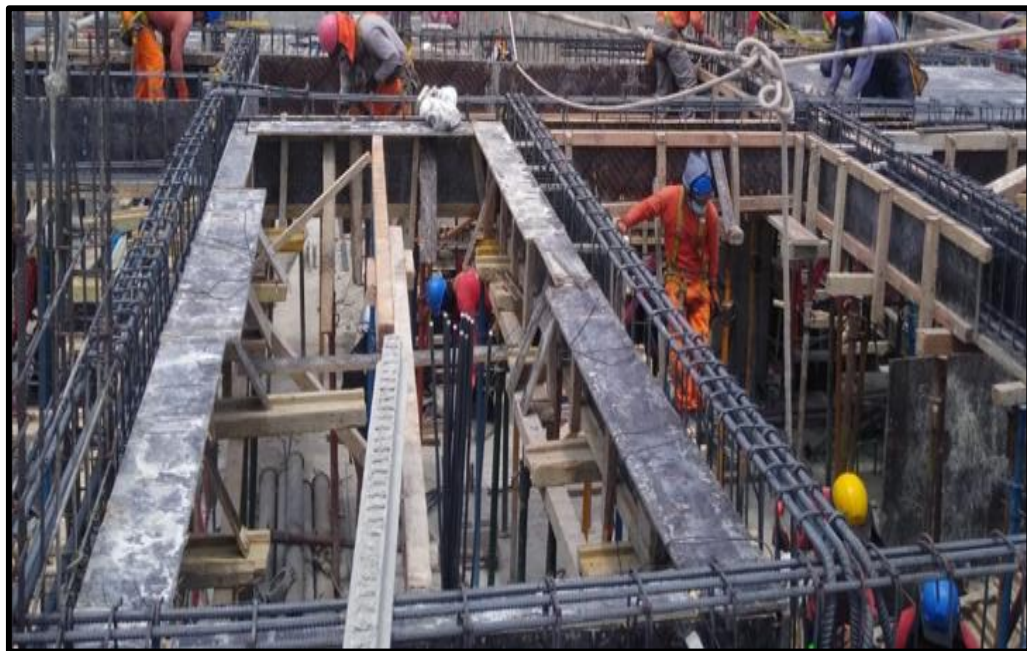
Encofrado para losa aligerada con vigueta pretensada Fuente: (propia 2021)
