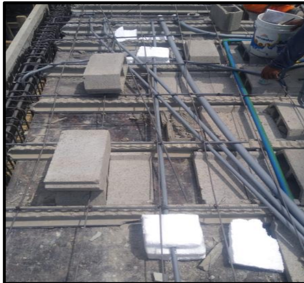
Colocación de acero de refuerzo Fuente: (propia 2021)
