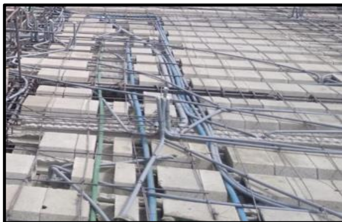
Tendido de tuberías eléctricos Fuente: (propia 2021)
