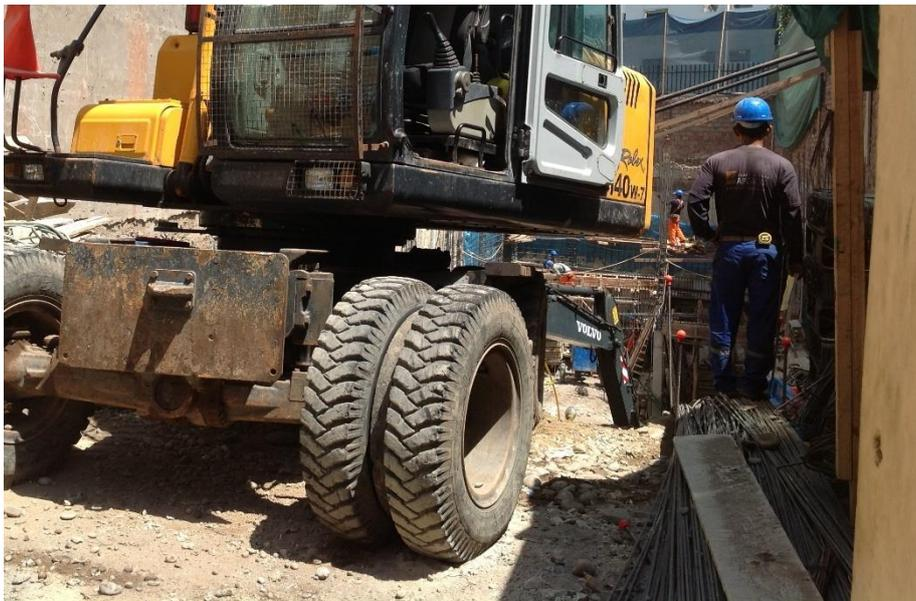
Figura 48. Acero almacenado innecesariamente en obra proyecto Spuknit – Surco
