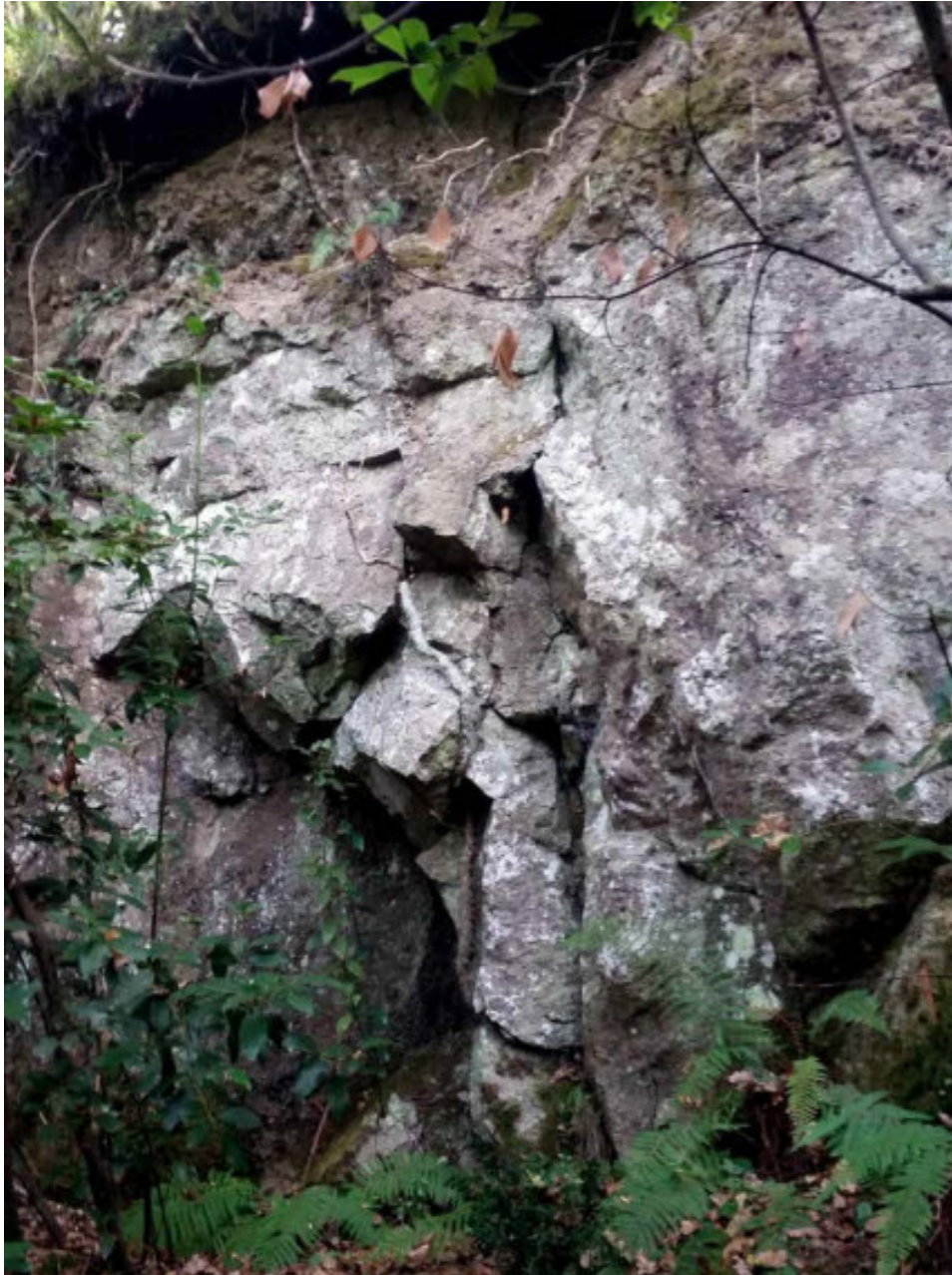
Figura 6.5 Fronte di cava in località Parata.
