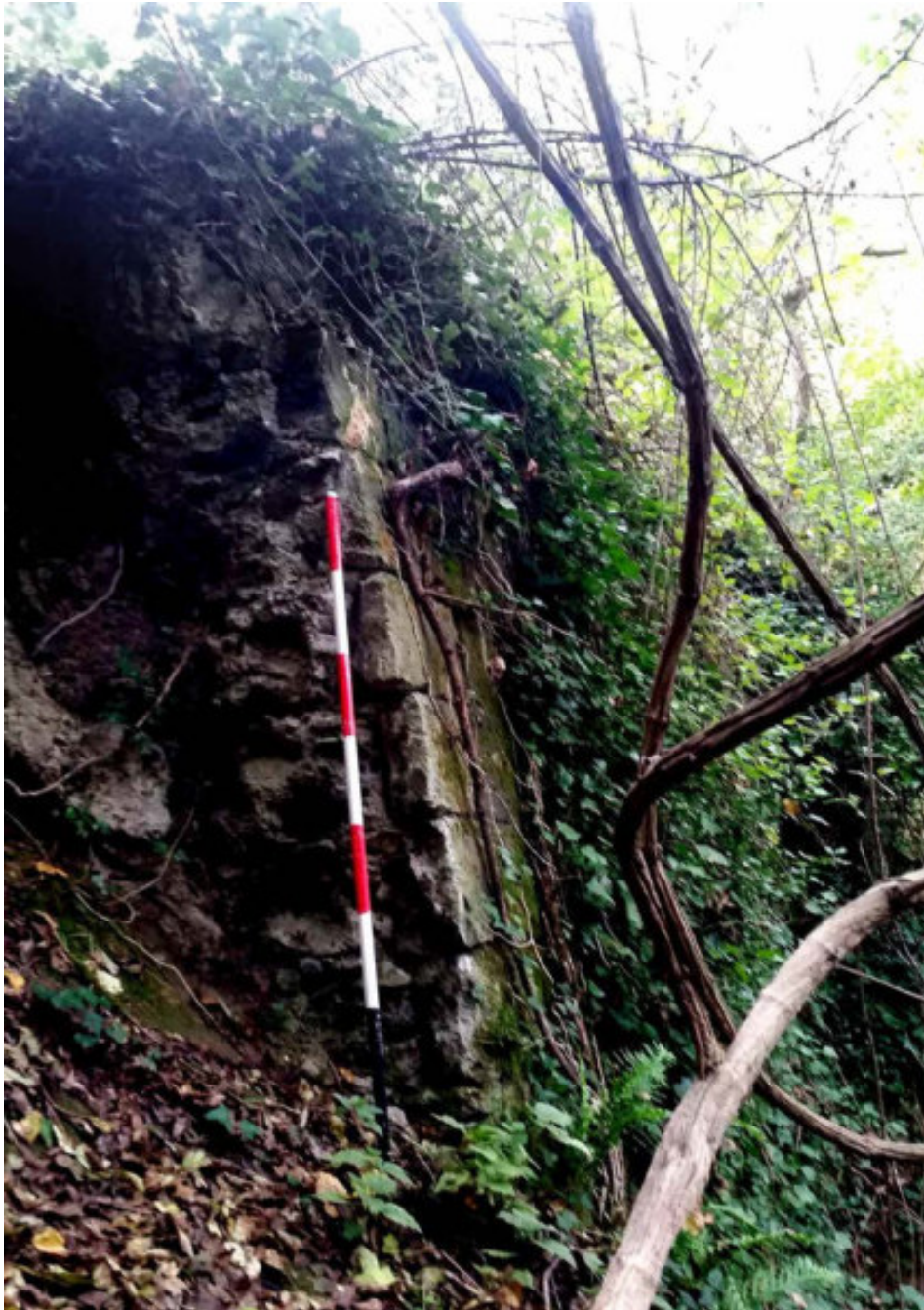
Figura 6.7 Mulino della Limatella. Muro di contenimento del bacino idrico.
