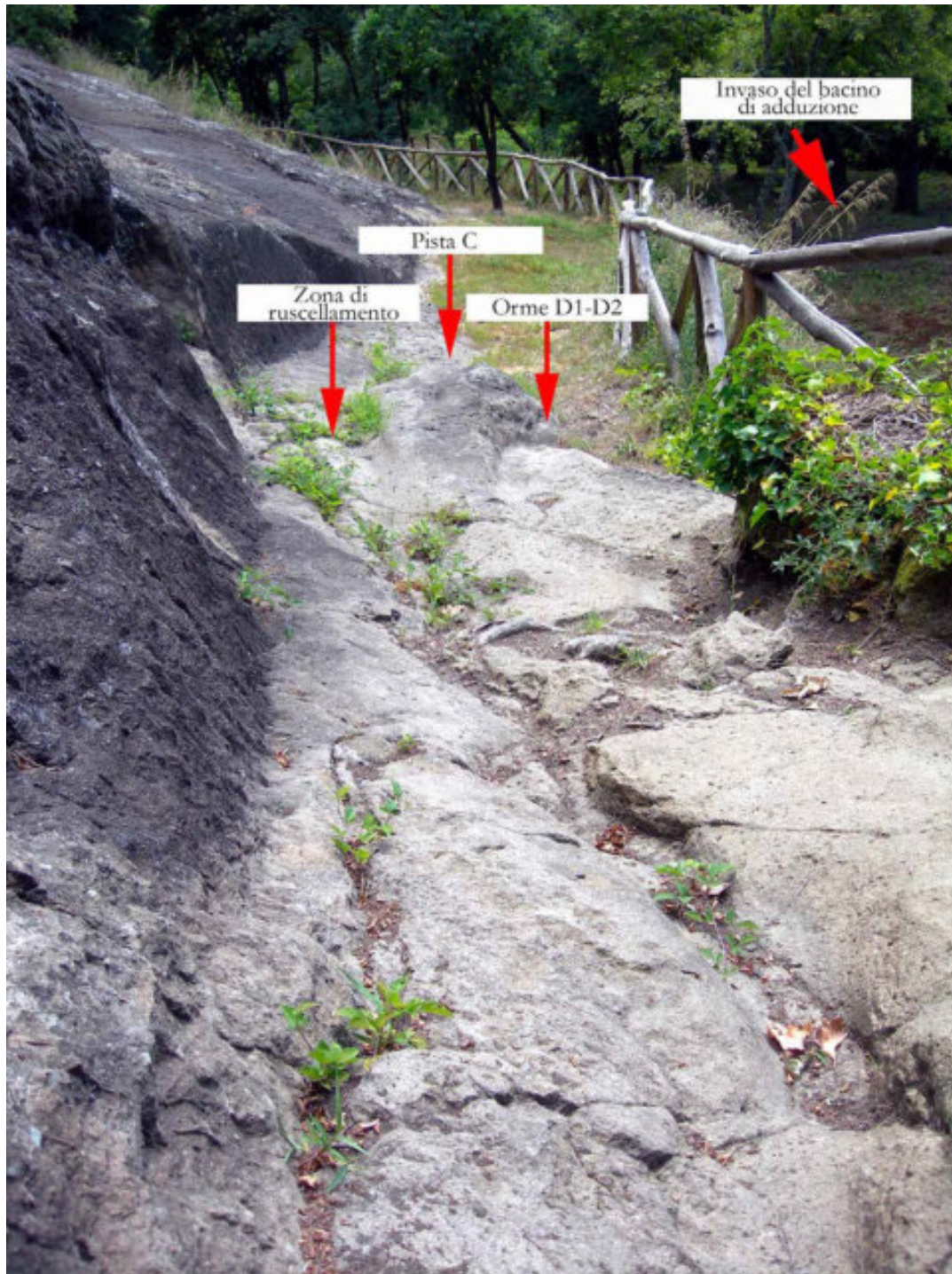
Figura 14.11 Fotografia prospettica, da Ovest, del sentiero basso. Il taglio antropico a monte è evidentissimo, al pari dell'alterazione del fondo, a causa della desquamazione, dell'intrusione delle radici e del taglio operato a colpi di zappa. Le direzioni delle piste di orme umane, la zona di ruscellamento e il dislivello dell'invaso sono evidenziati con le frecce in sovrimpressione.
