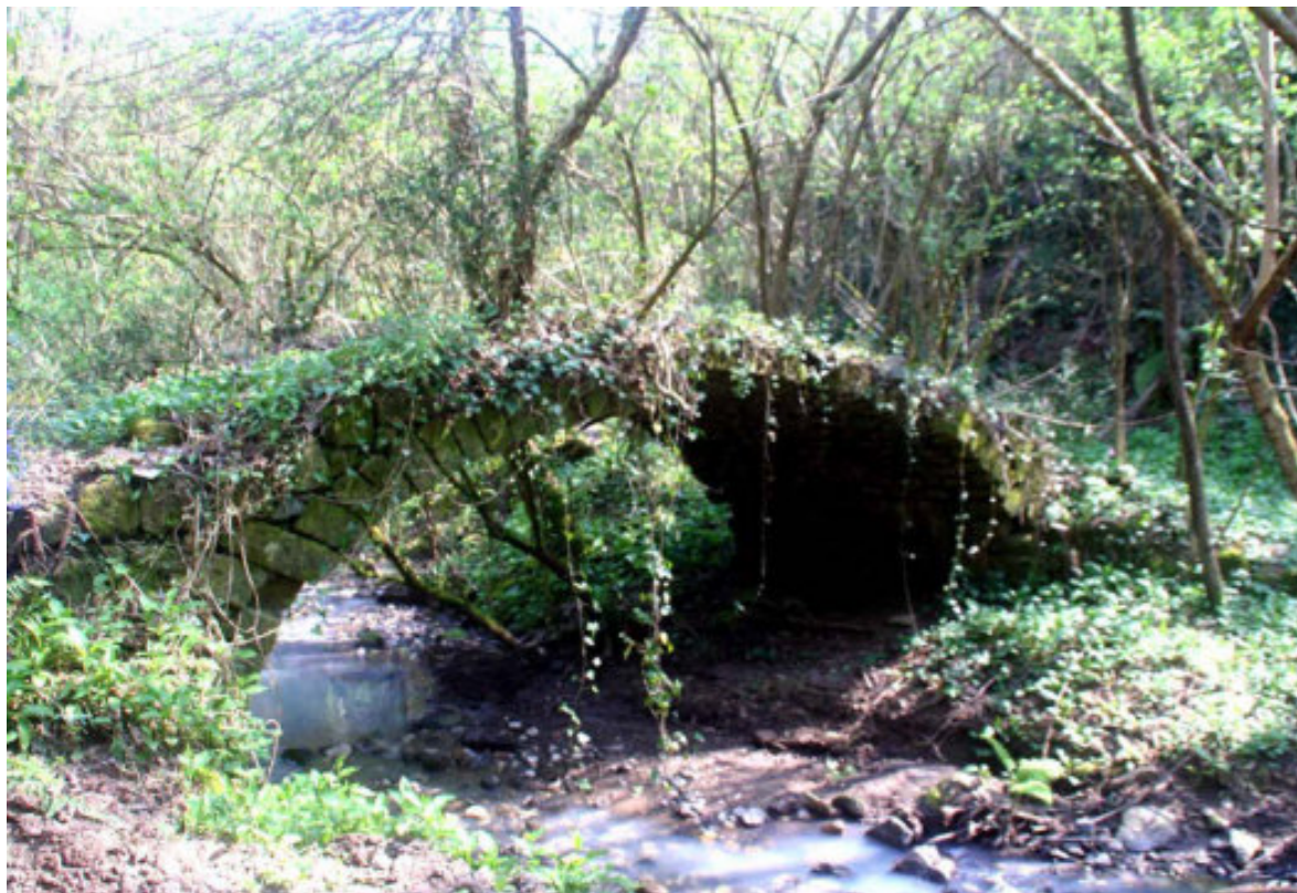
Figura 6.2 Ponte sul Fosso Rianale.
