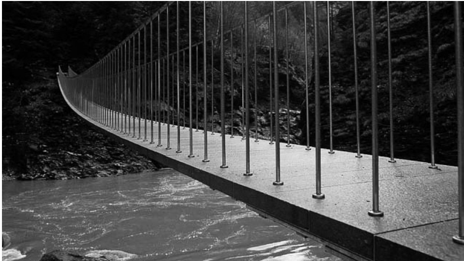
FIG. 18. PASSERELLA SURANSUNS_CONZETT_1999 (CBG-ING.CH).
