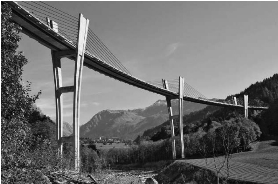
FIG. 9. PONTE SUNNIBERG_MENN_ 1999 (WWW.SWISS-HISTORIC-HOTELS.CH).
