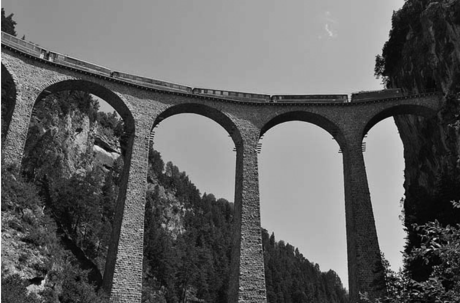
FIG. 1. PONTE DI LANDWASSER_FERROVIA DELL'ALBULA_1902 (WWW.FLICKR.COM, AUTORE: PATRICK FEDERI).
