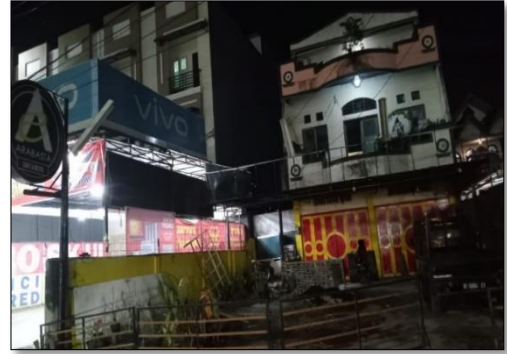
Gambar 5. Café yang sedang renovasi (sumber: Dokumentasi pribadi )
