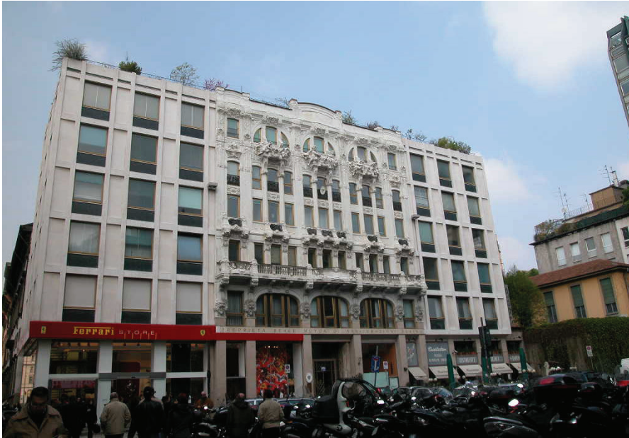
Figura 15. Prospetto dell'edificio di piazza del Liberty, con al centro la facciata ricomposta dell'albergo Corso oggi (foto S. Pesenti).
