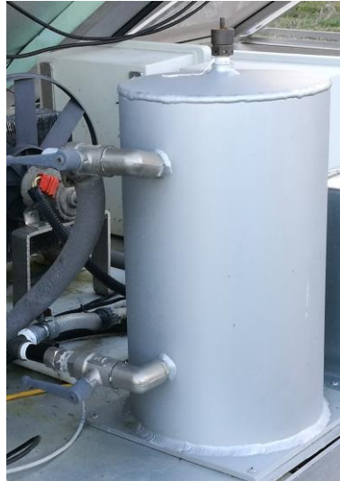
Figura 3.7 - Tanque do fluido térmico do sistema PVT estudado.
