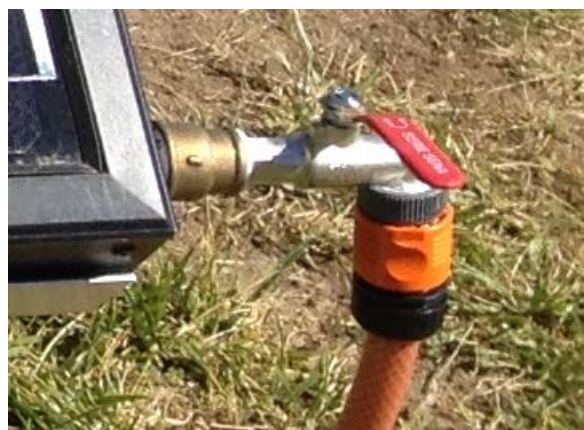
Figura 3.12 - Ligação do PVT à rede do fluido térmico.
