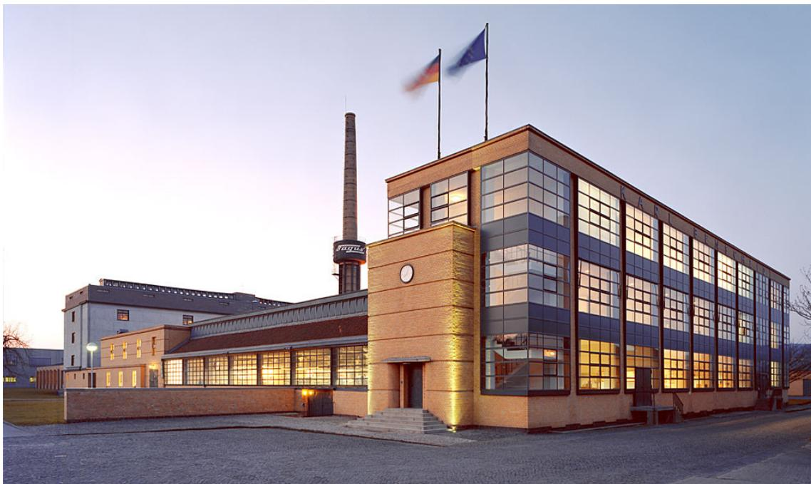
**Figura 8.** Edifício da fábrica de sapatos Fagus, desenhada por Walter Gropius e Adolf Meyer (1911-1913). A parede de vidro, elevada do lado direito da figura, é exemplar enquanto arquétipo, para o edifício da *Bauhaus*, em Dessau.
