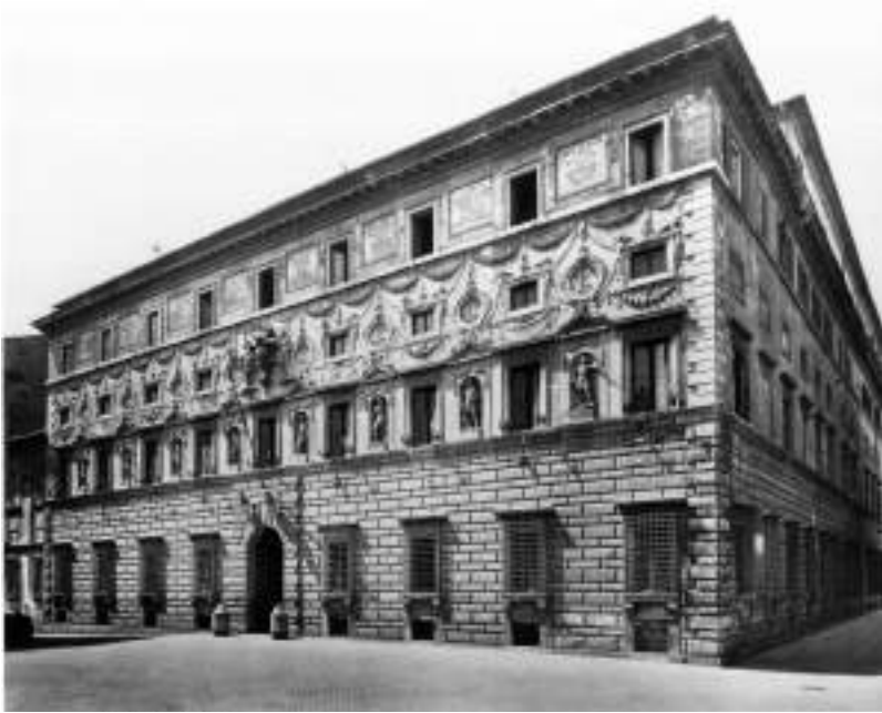
64. Roma, palazzo Capodiferro Spada, facciata
