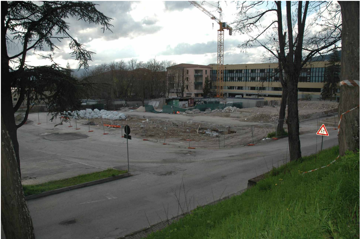
Sullo sfondo il Tribunale di L'Aquila, esempio di ricostruzione su un modello interpretativo dell'esistente con produzione di effetti "discutibili" delle nuove architetture urbane. In primo piano l'ampio ambito di sedime lasciato libero dalla demolizione dei fabbricati una volta insistenti sull'area e oggi in attesa.
