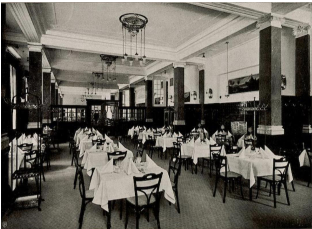
478 u. 479. Regina-Palast-Hotel; Speisesaal und Restaurant. Architekt Franz Lukas.
