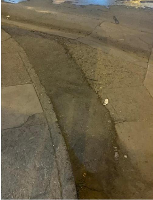
*Figura 33. Única rampa para personas discapacitadas en las vías de la intersección de las avenidas Vía de Evitamiento Sur y Atahualpa de la ciudad de Cajamarca.*
