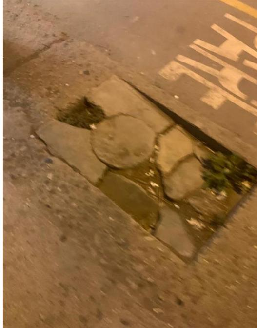
*Figura 29. Deterioro de la tapa de drenaje en la avenida Atahualpa de la ciudad de Cajamarca.
