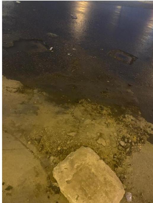
*Figura 32. Deterioro de la capa asfáltica con presencia de agujeros y desmonte en el pavimento en la intersección de las avenidas Vía de Evitamiento Sur y Atahualpa de la ciudad de Cajamarca.
