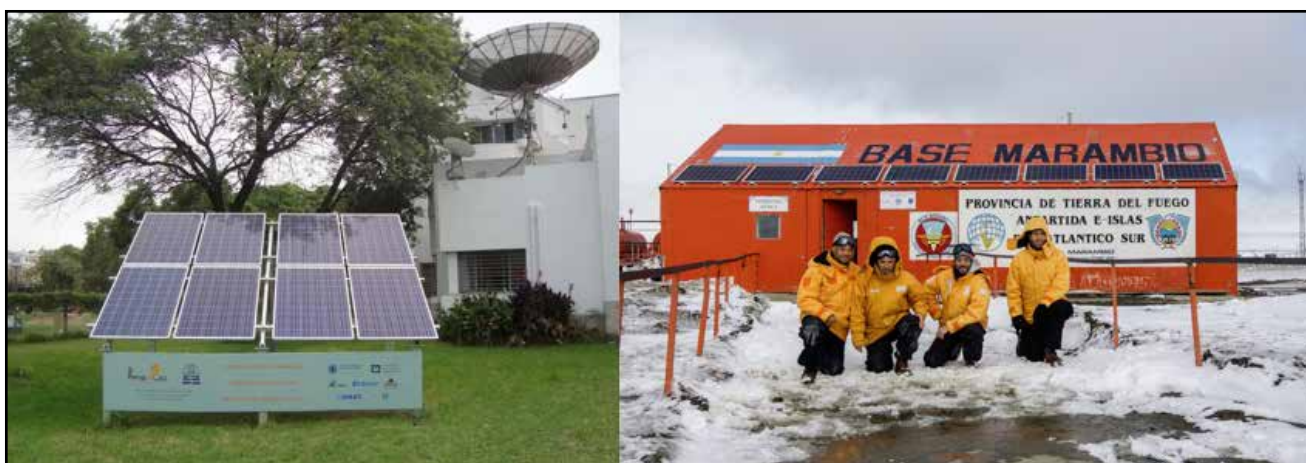
Figura 14: Sistema FV de 1,92 kW p instalado en la Asociación Argentina Amigos de la Astronomía (izquierda), y de 1,92 kW p en la base Marambio, Antártida Argentina (derecha).
