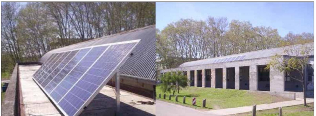
Figura 12: Sistema FV de 1,92 kW p instalado en la Universidad Nacional de Luján.
