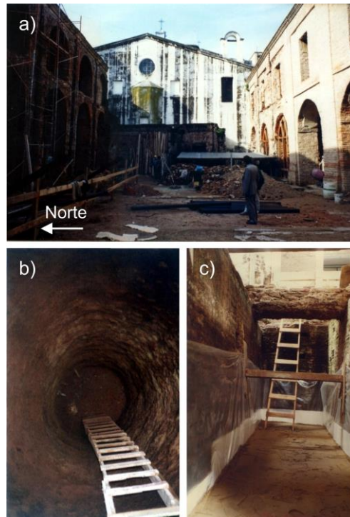
Figura 2. a) Foto de las excavaciones realizadas antes de la construcción del patio actual. b) y c) Fotos de una antigua cisterna (izq.) y una galería (der.), luego cubiertas.
