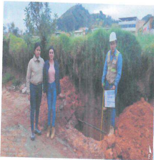
Fig.01: Excavación de calicatas en campo.
