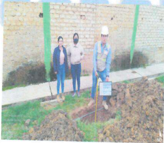
Fig.03: Excavación de calicatas en campo.
