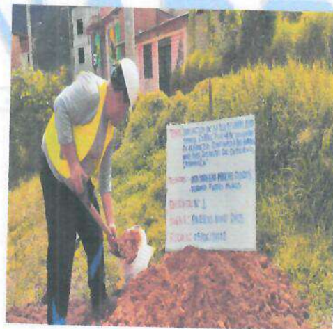
Fig.04: Excavación de calicatas en campo.
