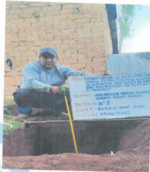
Fig.02: Excavación de calicatas en campo.
