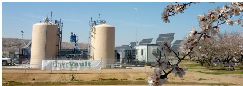
Figura 54. ICB de 1 MW/h de la empresa Enervault 138 .
