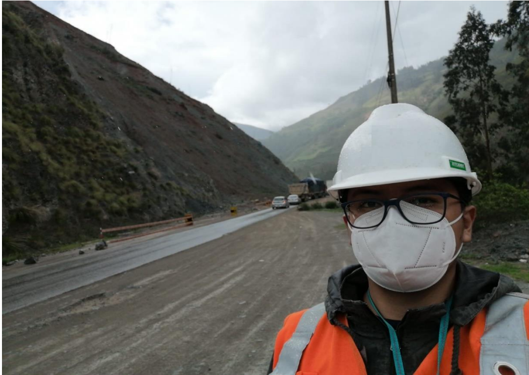
Inspección en campo de la ladera en el km 180+300 de la ruta PE-3N – San Rafael
