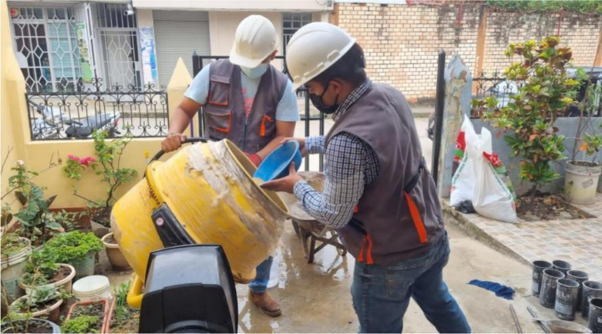
Fotografía 9. Elaboración de la mezcla de concreto.
