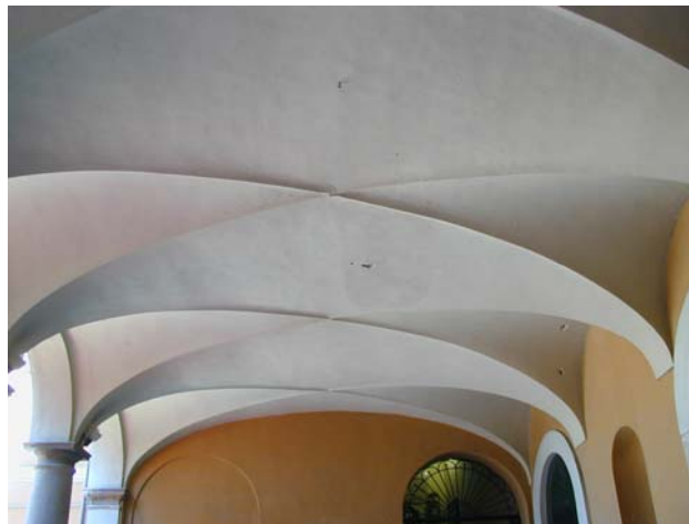
Fig. 3 - Porticato del corpo centrale di Villa Litta Modignani.
