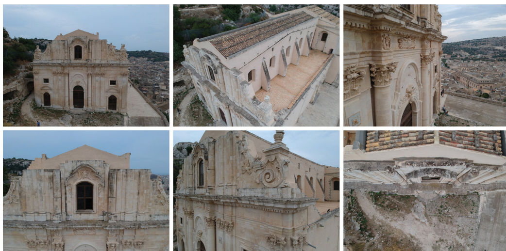
Fig. 01. Chiesa di San Matteo a Scicli: un esempio di architettura incompiuta (Laboratorio della Rappresentazione della SDS).
