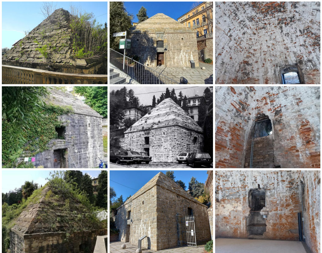
Fig. 08. Il torresino in via Beltrami a Bergamo: dopo il restauro degli anni '80 dello scorso secolo, nel primo decennio del nuovo secolo e in seguito agli interventi del 2021.
