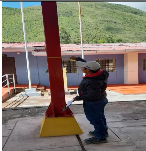
Vista de la toma de datos en las columnas de la Cobertura Portante
