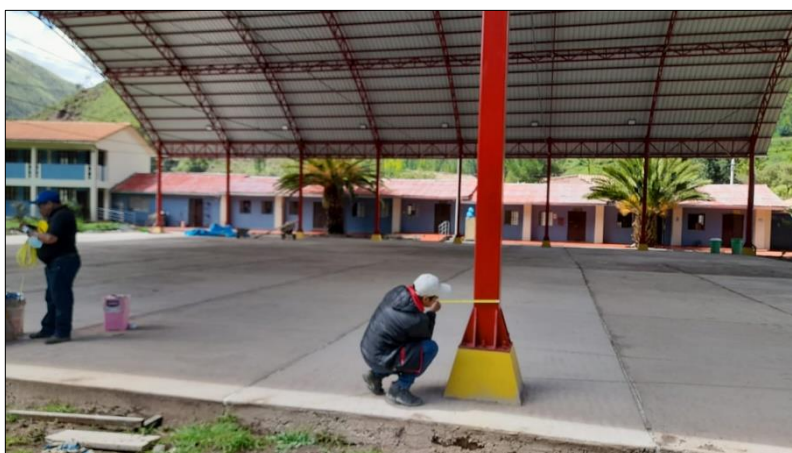
Figura 23: Toma de datos de la infraestructura
