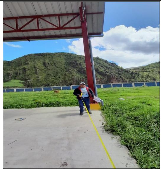
Vista de la toma de datos de largo y ancho de la Cobertura Portante.
