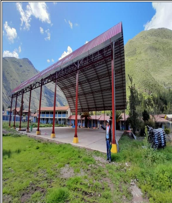
vista lateral del sistema de cobertura portante.
