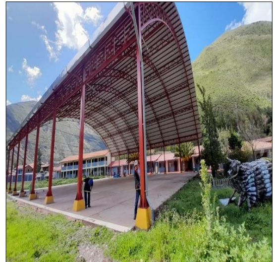
Vista de la toma de datos del sistema de cobertura Portante.
