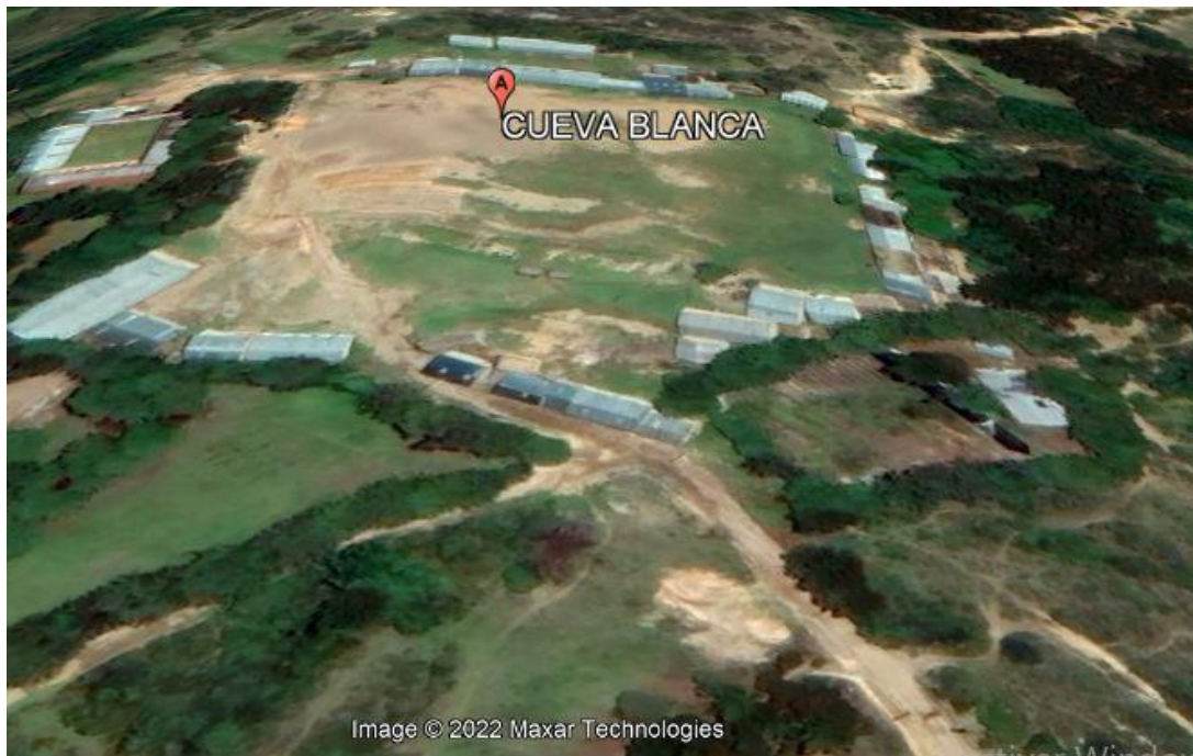
Figura 2. Ubicación de Instalación Sistema Fotovoltaico en Caserío Cueva Blanca
