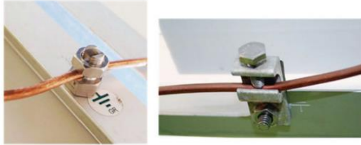
Figura 28. Correcta conexión de tierra (perno partido)
