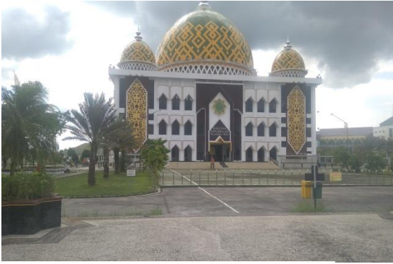
Gedung Masjid Raya Darussalam Palangka Raya
