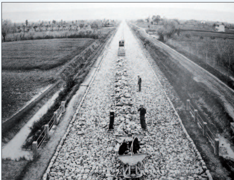
Realizzazione della fondazione autostradale sulla Venezia-Padova
