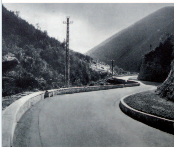
Ammodernamento sulla Via Flaminia
