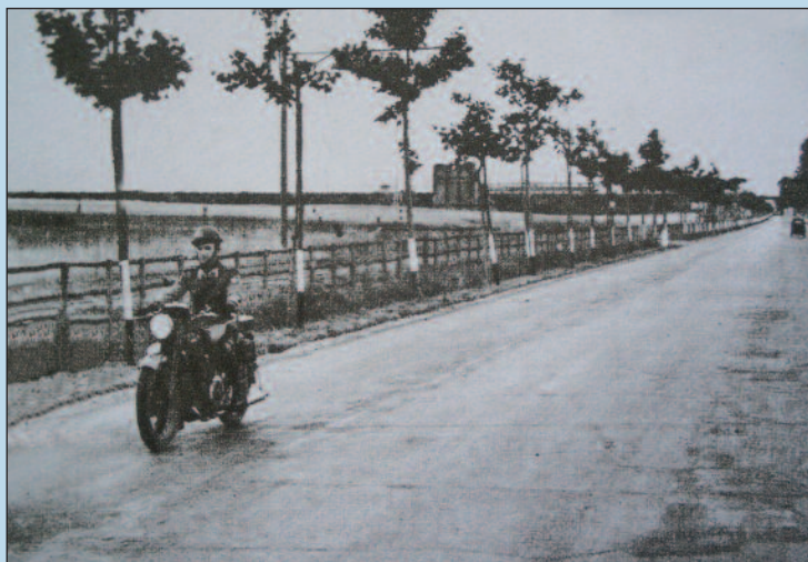
Alberatura con segnaletica integrata
