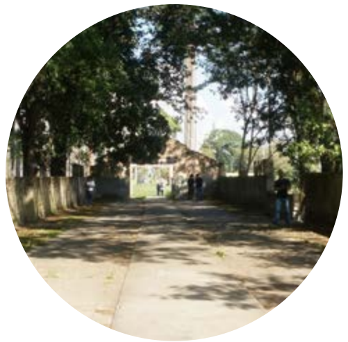
RUÍNAS DO GALPÃO DE ORDENHAS
