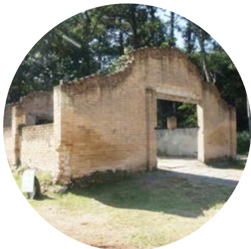
Ruínas Galpão de Ordenhas
