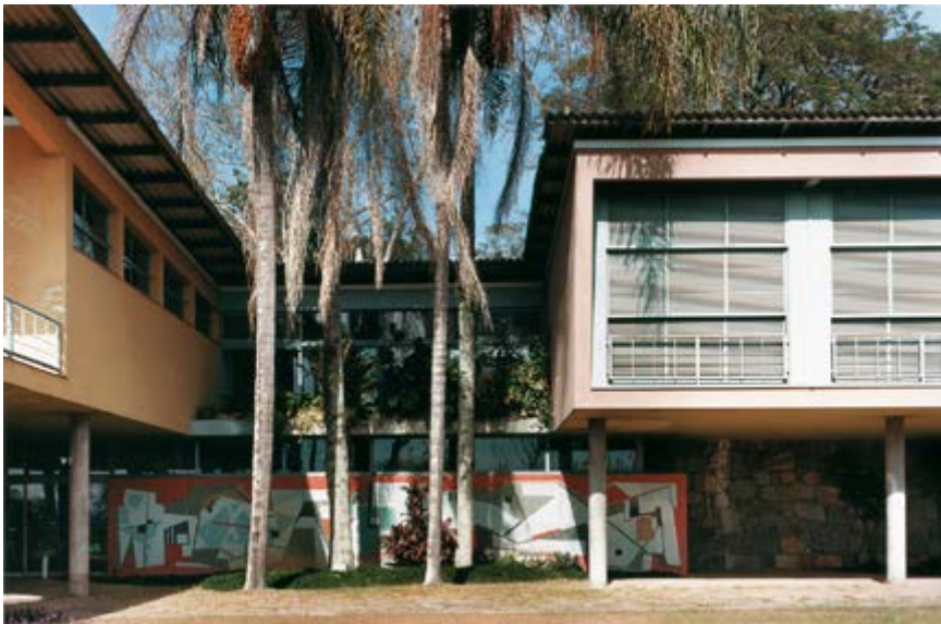
Nelson Kon. Vista da fachada nordeste. Painel de Roberto Burle Marx.
