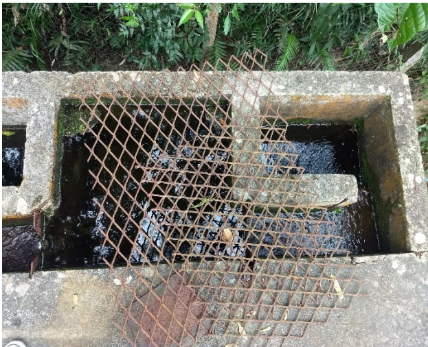
Figura 52 - Tanque de equalização e tubulações do sistema de tratamento de água.
