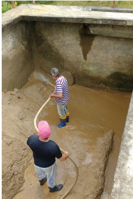
Figura 44 - Limpeza do leito filtrante lento na aldeia Coqueiro - José Boiteux
