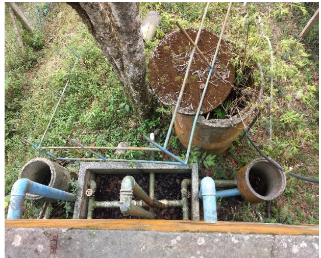
Figura 52 - Tanque de equalização e tubulações do sistema de tratamento de água.
