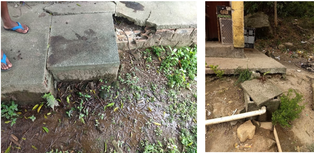
Figura 56 - Caixas de gordura
