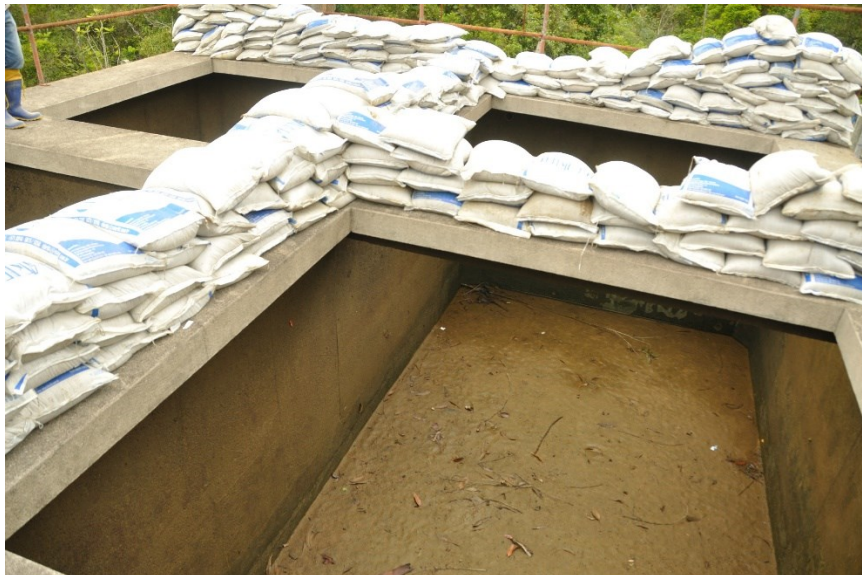
Figura 9 – Filtro lento na aldeia Coqueiro, Vitor Meireles – SC
