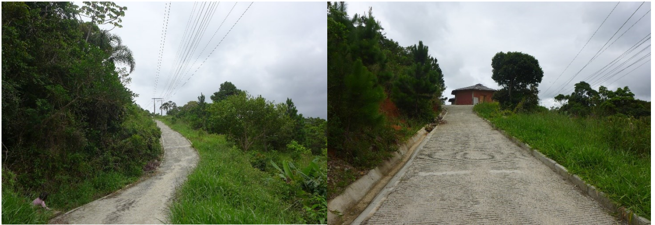
Figura 47 – Acesso principal dentro da aldeia Morro dos Cavalos, Palhoça – SC.
