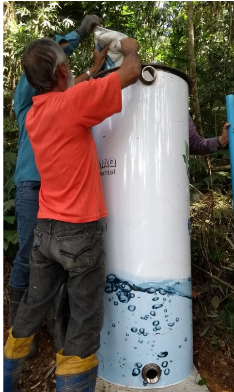
Figura 8 – Instalação filtro de pressão na aldeia Amaral – Biguaçu
