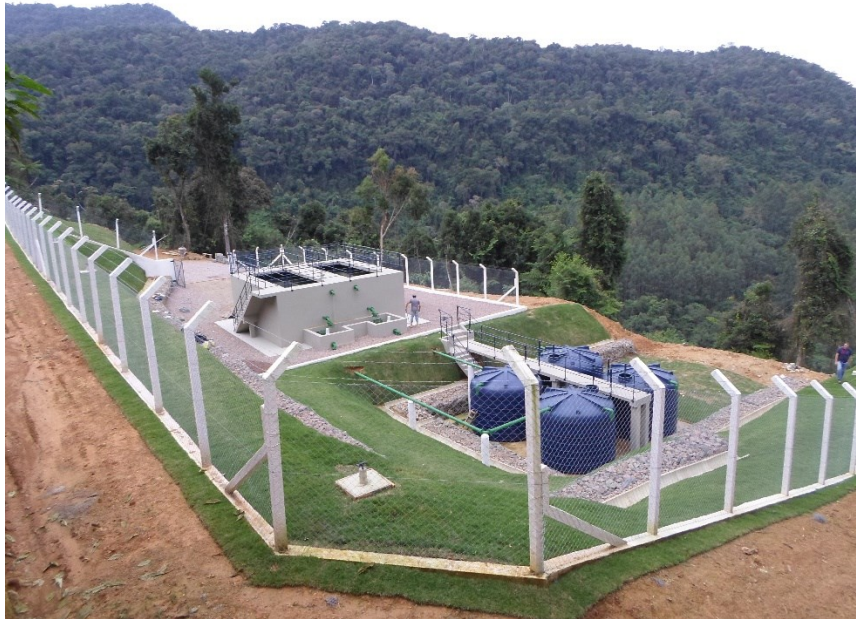
Figura 42 - Estação de tratamento de água na aldeia Pavão - José Boiteux (vista de cima)
