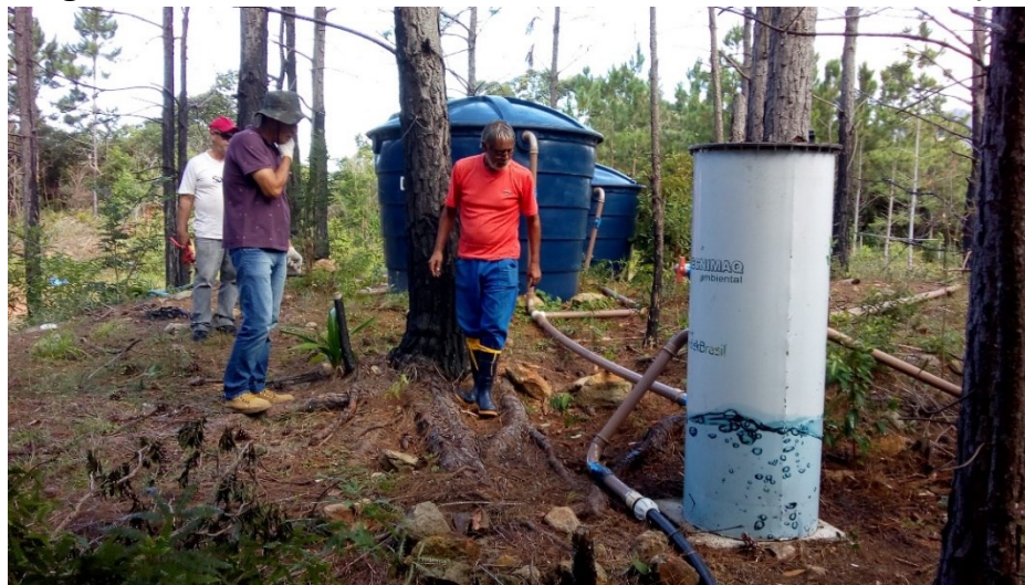
Figura 30 - Sistema de abastecimento na Aldeia Yakã Pora, Palhoça.
