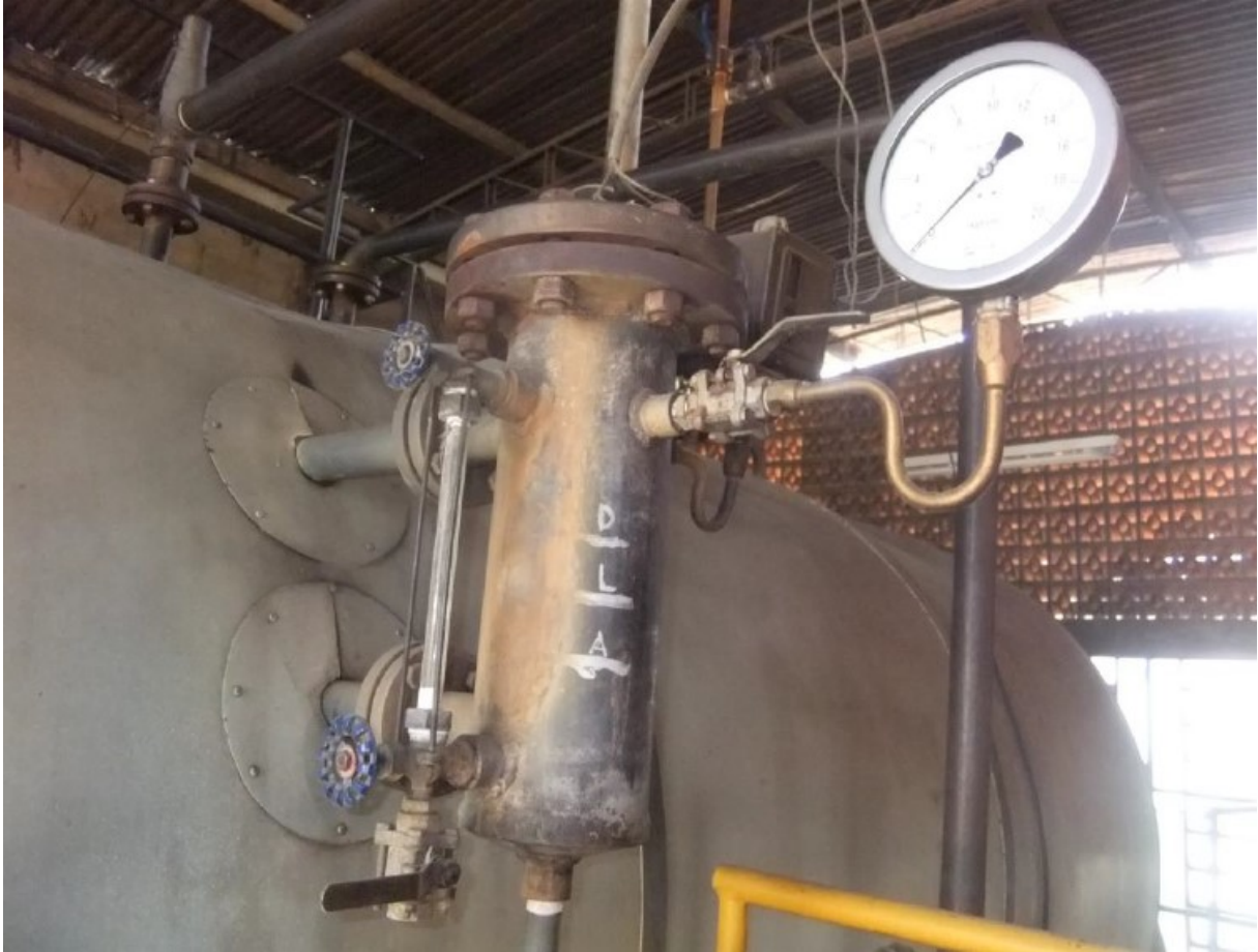
Figura 16 - Garrafa, Visor do nível de água e Manômetro
