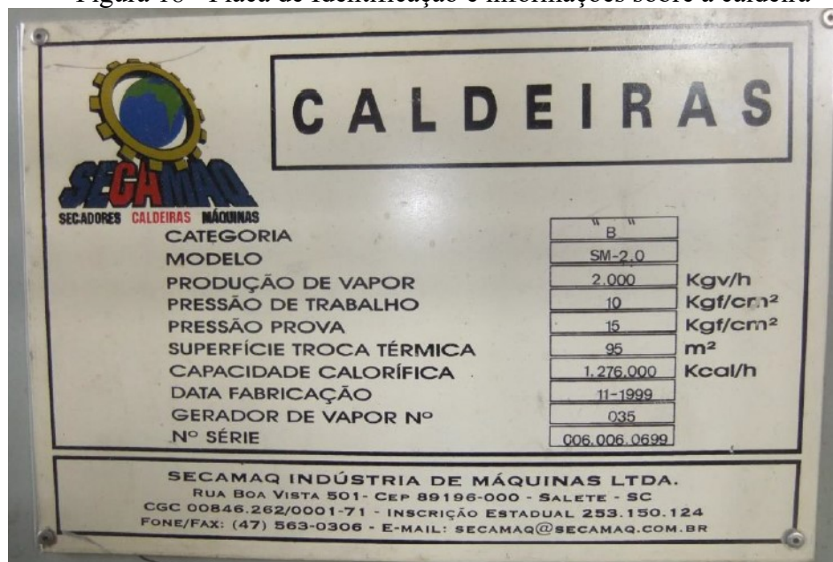
Figura 18 - Placa de Identificação e informações sobre a caldeira
