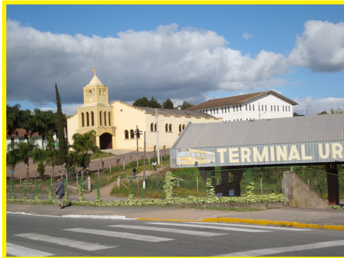
Terminal de Ônibus
