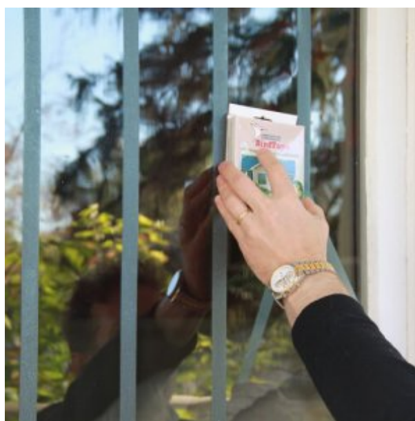
Figura 15 – Produto Bird Tape sendo colocado sobre a vidraça para evitar as colisões de avifauna
