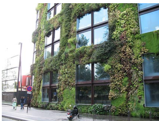
Figura 3 – Arquitetura verde composta por fachada com plantas em torno das janelas de vidro
