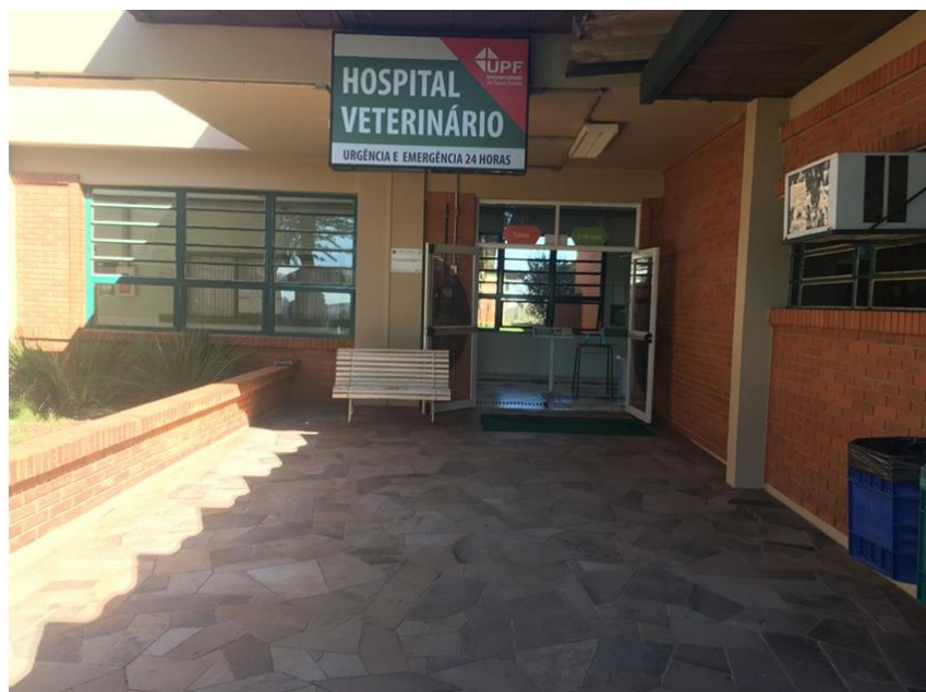
Figura 8 - Fachada do Hospital Veterinário da Universidade de Passo Fundo (UPF).
