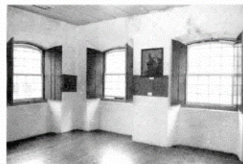
Uma das salas antes da restauração.
