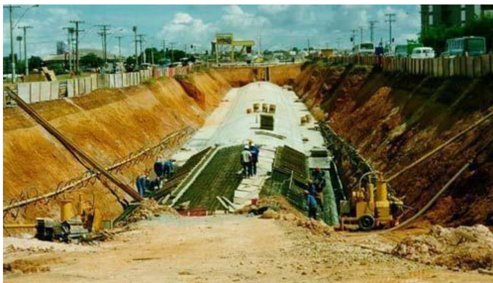
Figura 3 - Vala a céu aberto.
