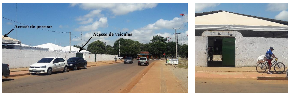
Figura 4: a) Rua de acesso ao abrigo e b) Portão de acesso de pedestres. Fonte: Autores (2018).
