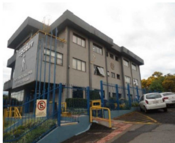
Figura 09 –Fachada lateral com acessos. Fonte: Autores
